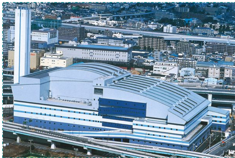
坐落于城市中心的垃圾发电站
