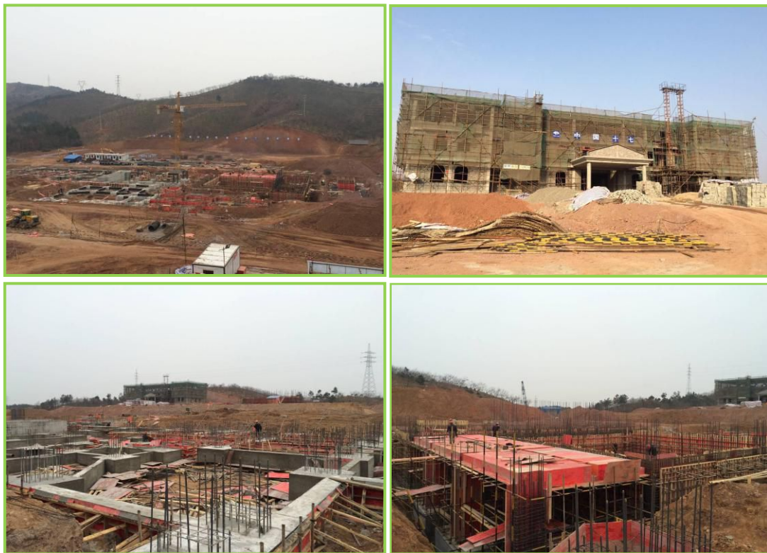
安徽金寨炉排炉项目正在建设中
