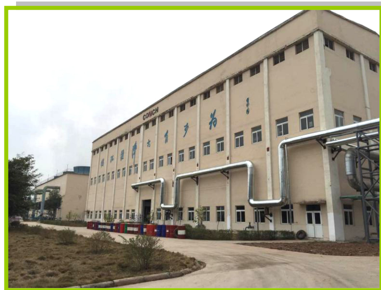
重庆海螺二期余热发电项目
