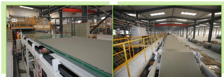
新材料项目厂房
