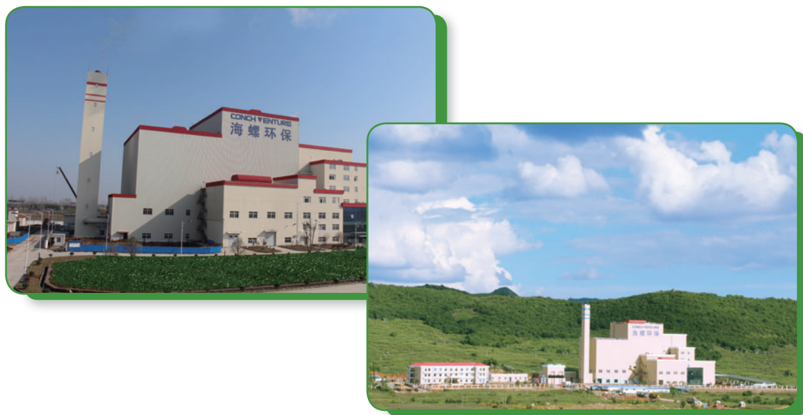
銅仁、硯山爐排爐項目投產運行
